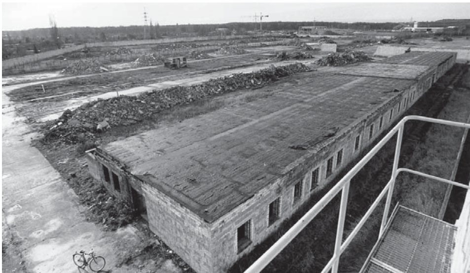
Die letzten Baracken des Lagers beim Abriss. Ein dunkles, nicht aufgearbeitetes Kapitel in der Dessauer Geschichte geht zu Ende. Quelle: Stadtarchiv Dessau-Roßlau
