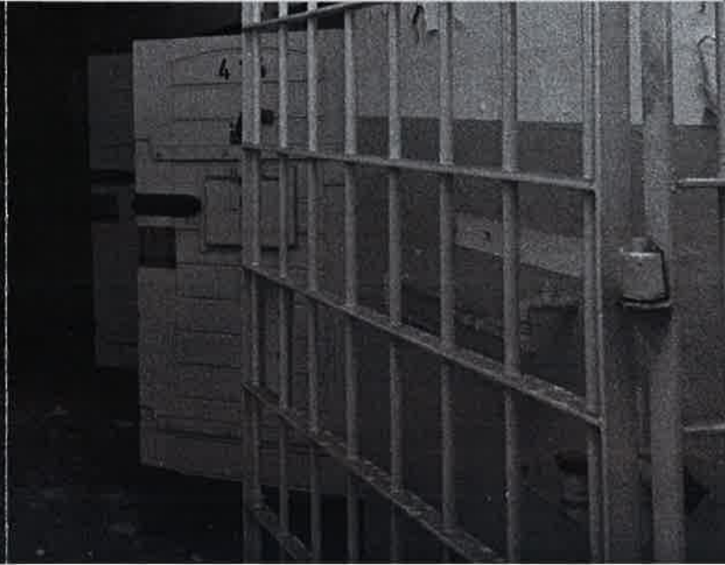
Ehemaliges Gefängnis Gartenstraße (Frankfurt/Oder) nach der Wende Foto: Hartmut Kelm
