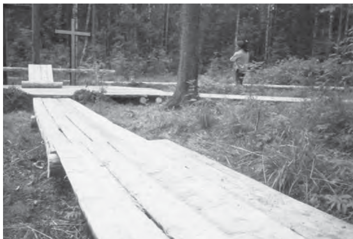
Im Sommer 1998 wurde der Waldfriedhof Padosero als Gedenkort eingeweiht. Wegen des sumpfigen Untergrunds mußten Holzstege verlegt werden.
