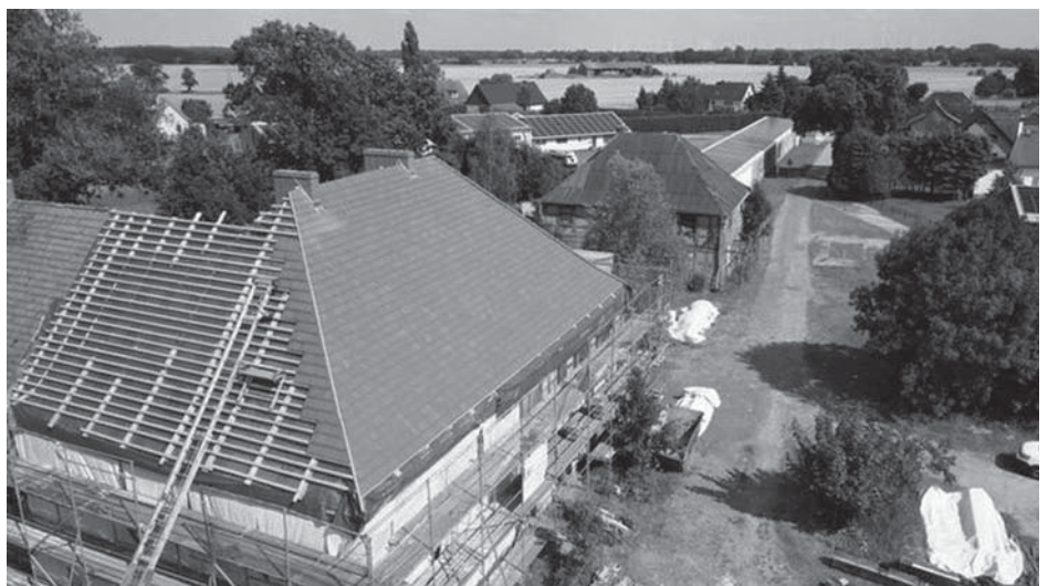
Bauvorhaben Plänitz 2024 bis Herbst 2025, 165 m 2 . Neueindeckung des Herrenhauses mit neu errichteten Schornsteinköpfen und Entwässerung. Fotorechte ARE
