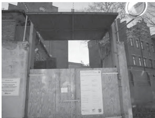
Schon der Eingangsbereich läßt erkennen, daß aufwendige Bauarbeiten im Gange sind.
