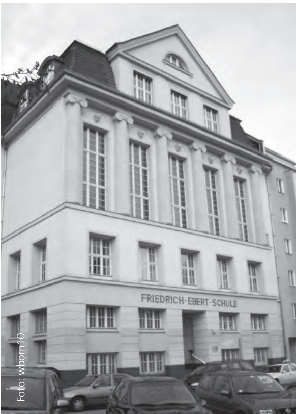
Das Friedrich-Ebert-Gymnasium in Berlin-Wilmersdorf.
