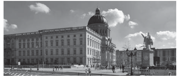
Berliner Schloßplatz mit dem Humboldt Forum im Vordergrund und dem ehemaligen Staatsratsgebäude im Hintergrund. Text und Foto: Thomas Tews
