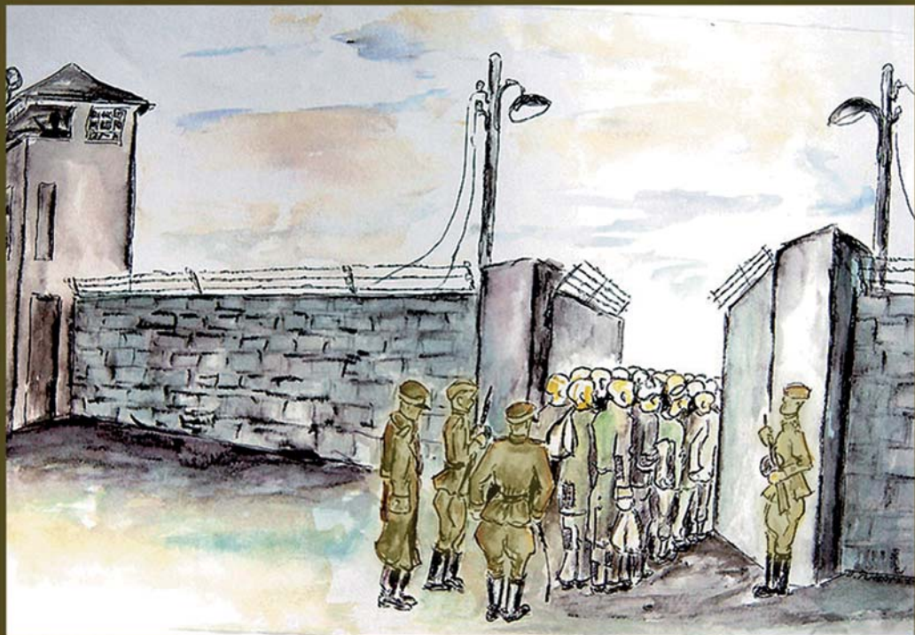
Zeichnung: Detlev Putzar, Lagerdurchgang Sachsenhausen 1947
